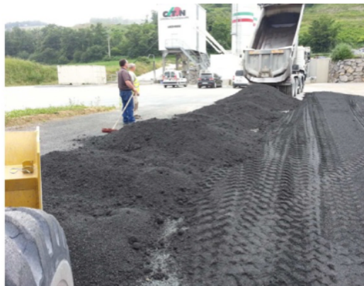
Figura 4. Equipo empleado para la puesta en obra.
