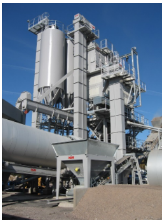
Figura 5: En primer término, tolva para la incorporación de una fracción de material fresado, a temperatura ambiente, directamente a la mezcladora.
